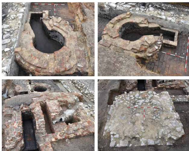
Obr. 10: 1 – umístění nejmladších bloků vytápěných párou; 2 – blok vytápěný párou včetně kovového potrubí; 3 – zázemí pro parní kotel Tischbein; 4 – kamenný základ pro komín. Foto: vše NPÚ Ostrava
