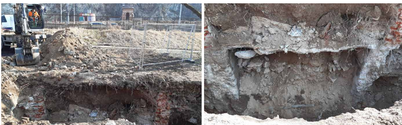
Obr. 9: Dokumentace z bagrování skrze historický objekt čerpací stanice – základové zdivo a podzemní betonová nádrž. Foto Zbranek, H. – Archaia Brno, z. ú.
