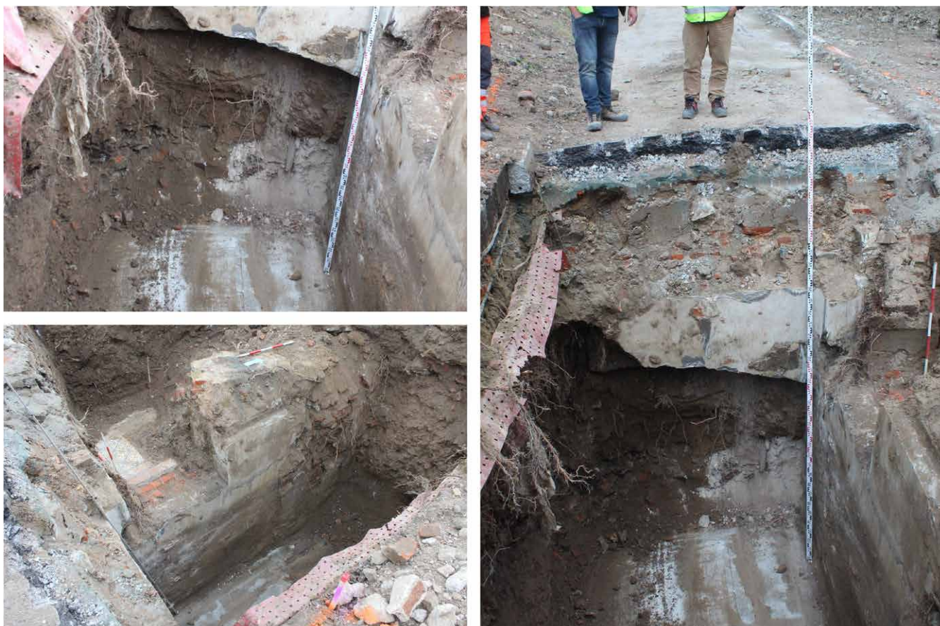
Obr. 13: Částečně vyčištěný betonový náhon z počátku 20. století. Foto Zbranek, H. – Archaia Brno, z. ú.
