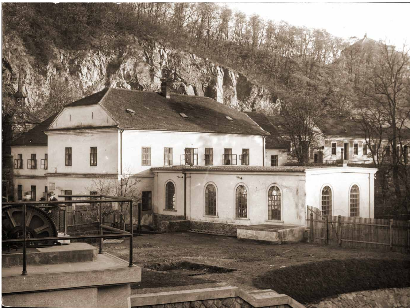
Obr. 5: Historická fotografie čerpací stanice vody v Kamenném Mlýně. AMB, fond U5 Sbirka fotografií, sign. XIXb 71
