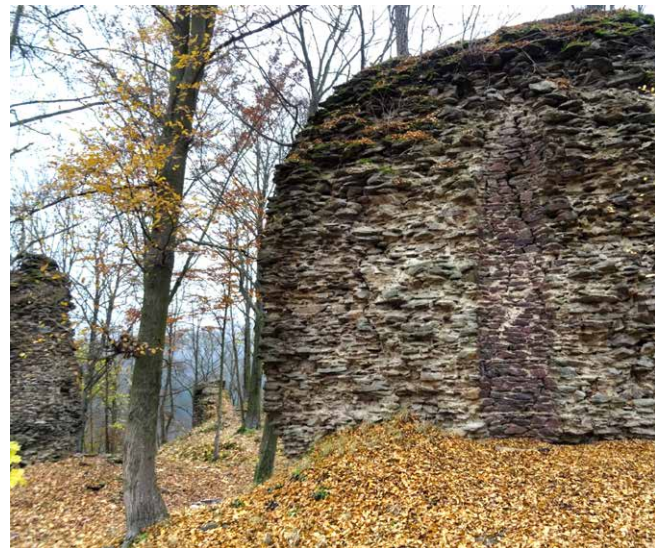
Obr. 2 Pozůstatky bergfritu a dvou opěrných pilířů. Foto L. Korbář
