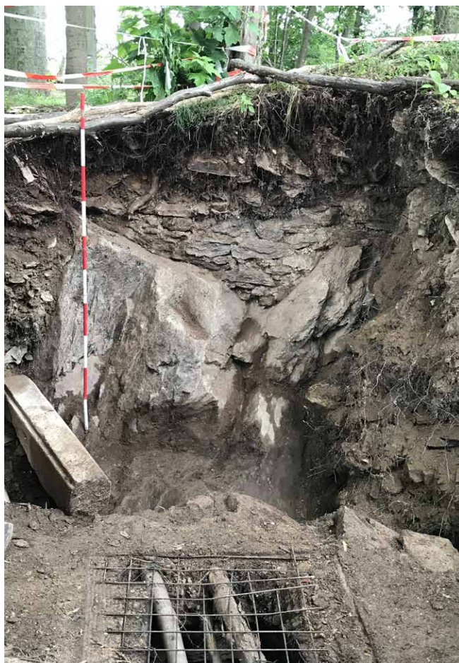
Obr. 13: Palácová zeď, stavební článek, obezdívka cisterny v popředí. Foto M. Korbičková
