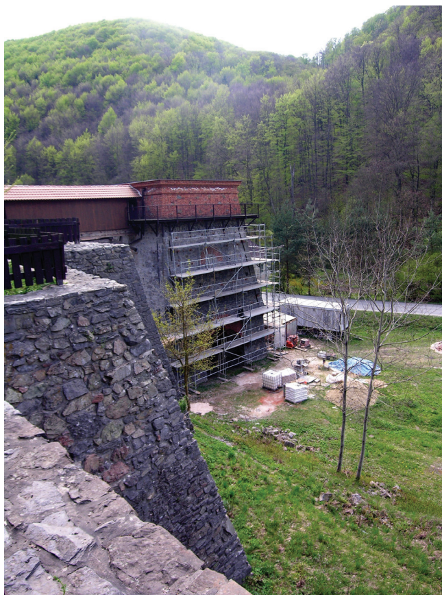
Obr. 38: Souběžně s opravou vnitřní vyzdívky pece v roce 2007 probíhalo i spárování jejího pláště. Foto: Jiří Merta
