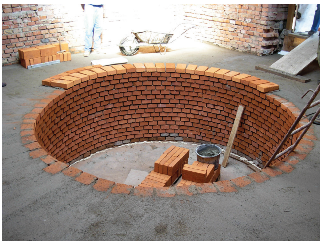
Obr. 37: Oprava vnitřní vyzdívky vysoké pece v roce 2007. Foto: Jiří Merta
