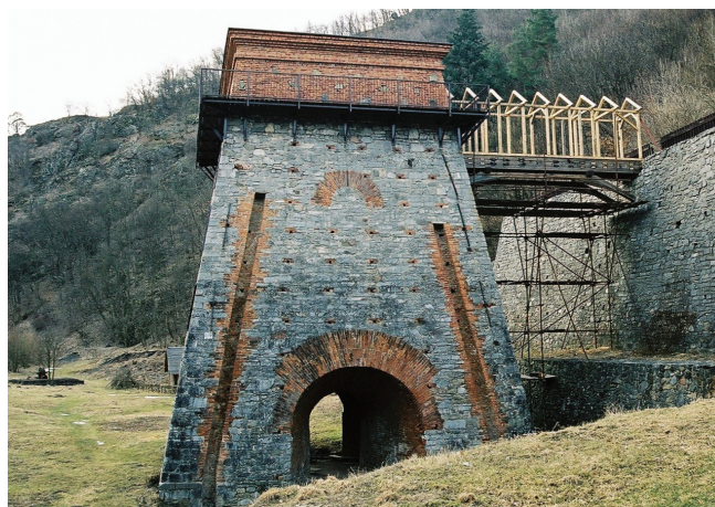
Obr. 34: Stavba nového zavázečního můstku vysoké pece. Stav v březnu 2003. Foto: David Merta
