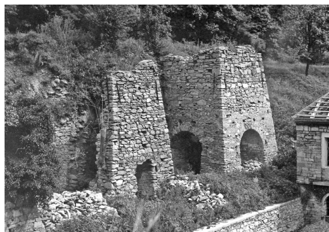
Obr. 18: Pece I a II (vápenky) v roce 1971 před opravou. Archiv TMB
