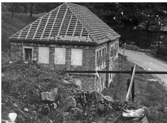
Obr. 21: Kameňák s novým krovem, fotografovaný z koruny vysoké pece v roce 1971. Archiv TMB
