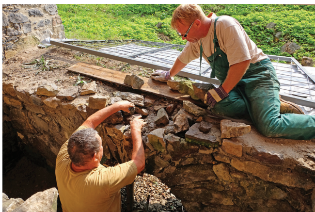
Obr. 43: Drobna oprava klenby prostupu z východního výklenku vysoké pece do náhonu. Pracuje Antonín Chaloupka, přihlíží Michal Křehlík. Foto: Ondřej Merta
