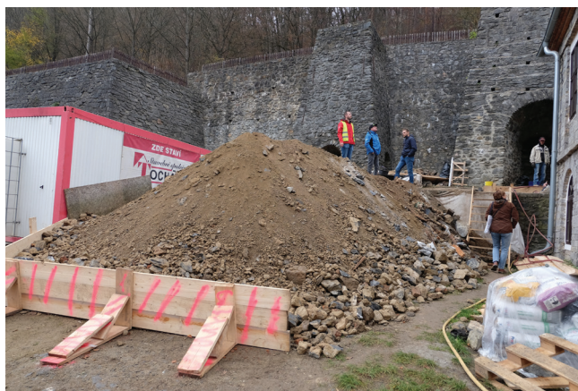
Obr. 46: Práce související s odvlhčením budovy Kameňáku – zemina vyvezená při hloubení dutiny mezi svahem a severní zdí budovy, 2022. Foto: Ondřej Merta
