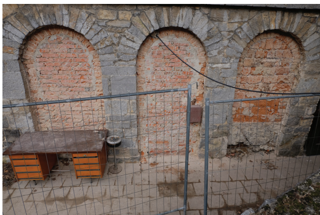
Obr. 45: Odstraněné omítky v přízemí východní strany budovy Kameňáku odhalují trojici zazděných oken. Právě bylo pro účely osvětlení prostoru pokladny obnoveno, 2022. Foto: Ondřej Merta
