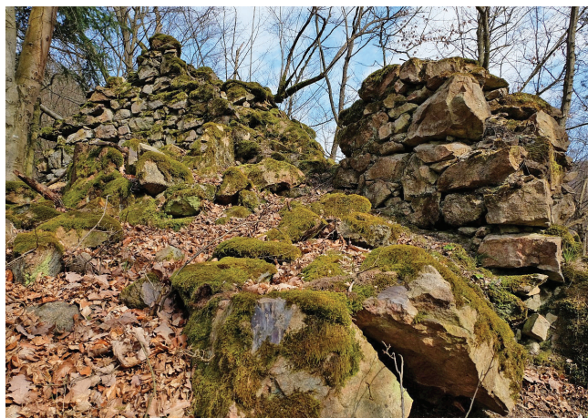
Obr. 10: Dochovaná část romantické zříceniny na ostrohu zakončujícím hřbet západně huti, 2016. Foto: Ondřej Merta
