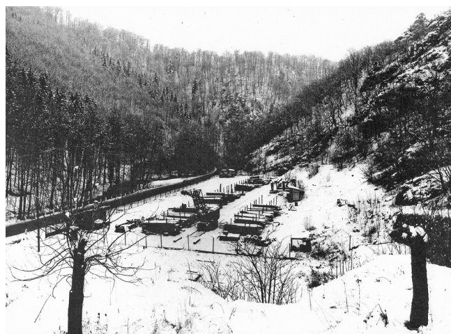
Obr. 22: Sklad materiálu ve východní části areálu bývalé huti. Přelom 60. a 70. let 20. století, několik uříznutých patek plotu slouží v současnosti k umístění vlajkových žerdí při akcích pro veřejnost. Archiv TMB
