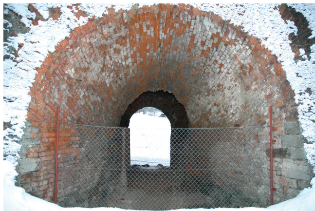
Obr. 36: Stav východního pracovního výklenku vysoké pece v roce 2006. Vstup do pece byl zahrazen, neboť hrozilo nebezpečí úrazu padajícími částmi vnitřní vyzdívky. Foto: Jiří Merta
