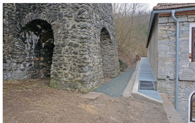
Obr. 49: Uzavření větrací dutiny při severní zdi Kameňáku mřížovím, 2023. Foto: Ondřej Merta
