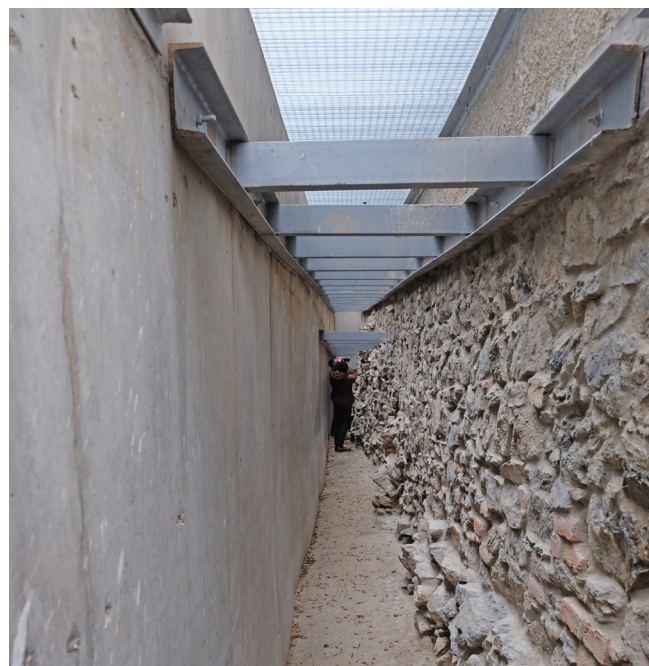
Obr. 48: Vnitřní prostor větrací dutiny u severní zdi Kameňáku po dokončení v roce 2023. Vzhled líce zdiva umožňuje rekonstruovat původní tvar terénu za budovou. Foto: Ondřej Merta
