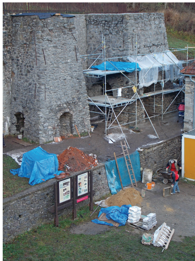
Obr. 41: Spárování plášťů vápenných pecí v zimě 2014. Foto: Ondřej Merta
