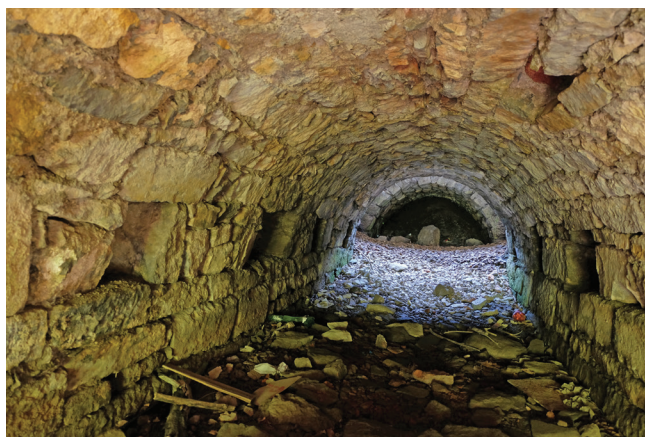
Obr. 44: Pohled do prostoru klenutého náhonu probíhajícího pod vysokou pecí. Celková světlost činí 202 cm, z čehož je větší polovina zanesena a stále pod hladinou spodní vody, 2021. Foto: Ondřej Merta
