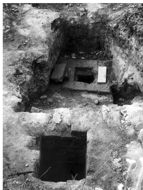
Obr. 24: Kontrolní čistící šachta náhonu, srpen 1971. Archiv TMB
