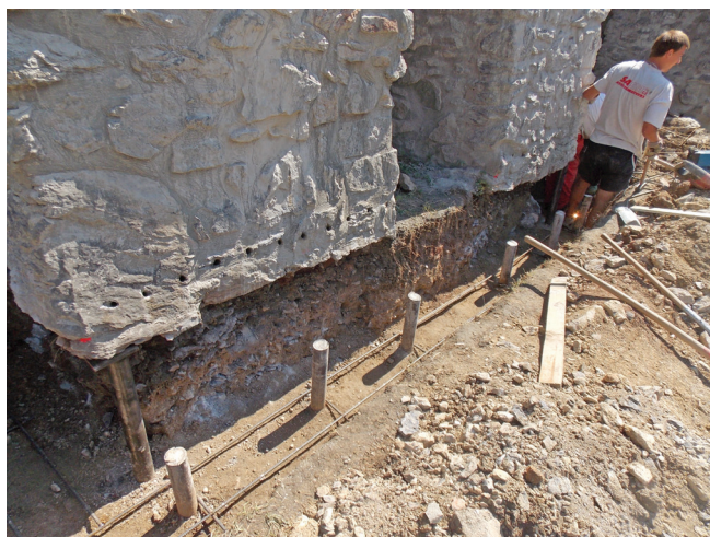
Obr. 40: Zabezpečení vápenných pecí postrádajících základ v roce 2014. Foto: Ondřej Merta
