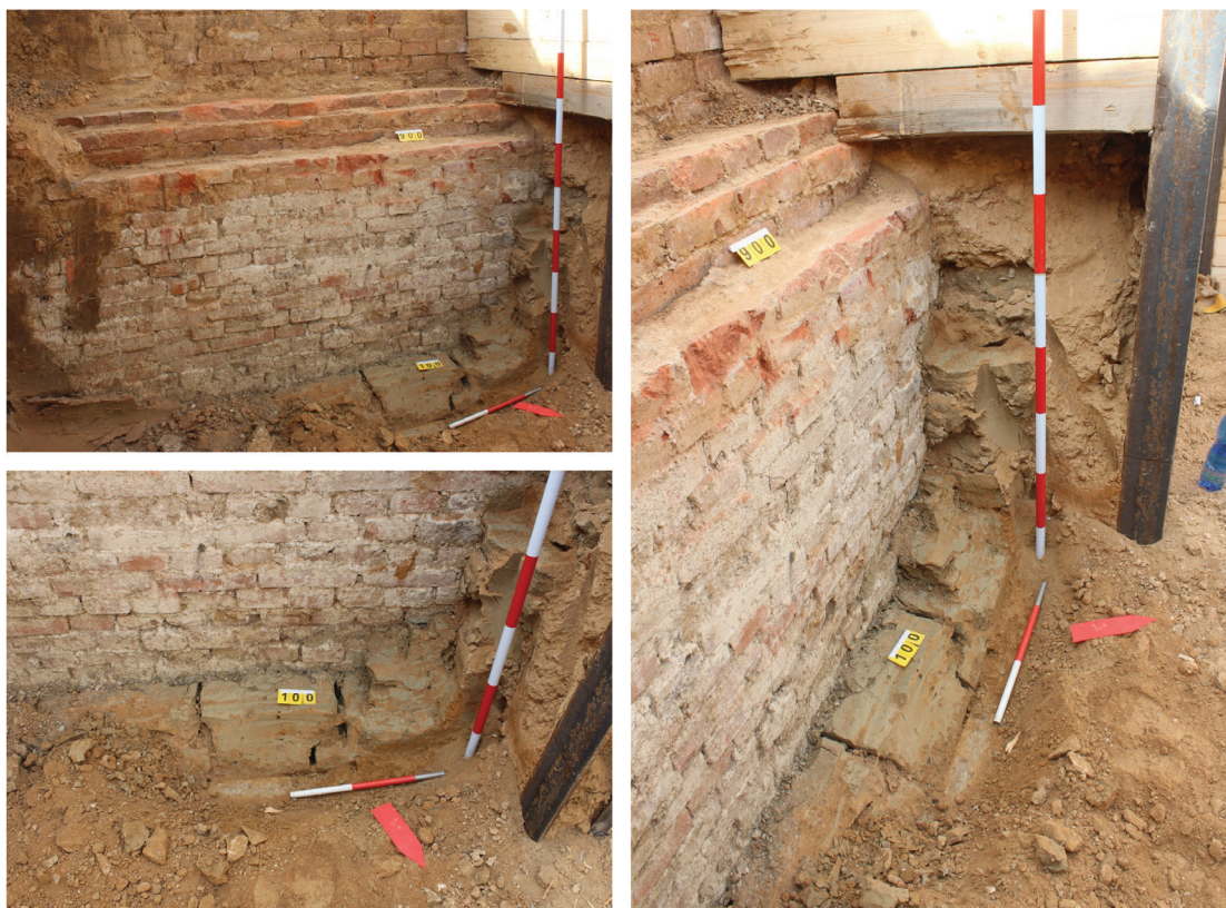
Obr. 7: Sonda S1, pohled na odkryté zdivo vodojemu z roku 1894 (s. j. 900 a 901) včetně zajílování pomocí jílových kostek (s. j. 100). Foto: H. Zbranek. Archaia Brno, z. ú.
