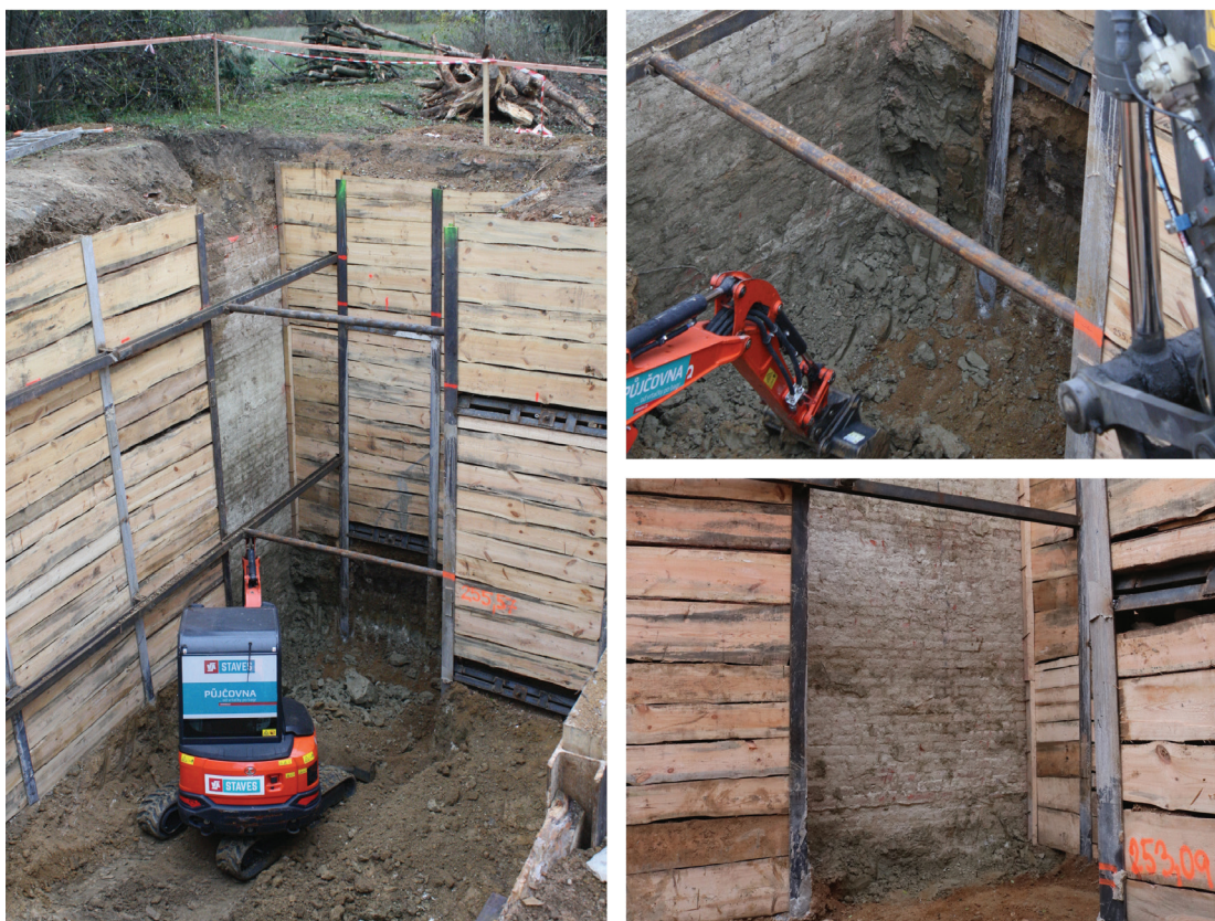
Obr. 13: Sonda S5, celkový pohled na zdivo vodojemu z roku 1874 (s. j. 902) a zajílování (s. j. 101). Foto: H. Zbranek. Archaia Brno, z. ú.
