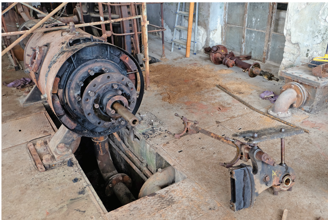
Obr. 9: Demontáž parního stroje, viditelná je izolace válce cihlami, srpen 2019. Foto: Ondřej Merta
