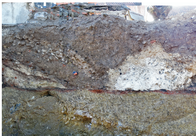
Obr. 4: Detail jihovýchodní stěny jámy se zbytky vápna – vlevo vyplňující spodní rohovou část miliře, vpravo středový bočník nezpracovaného vápna. Foto: P. Nový
