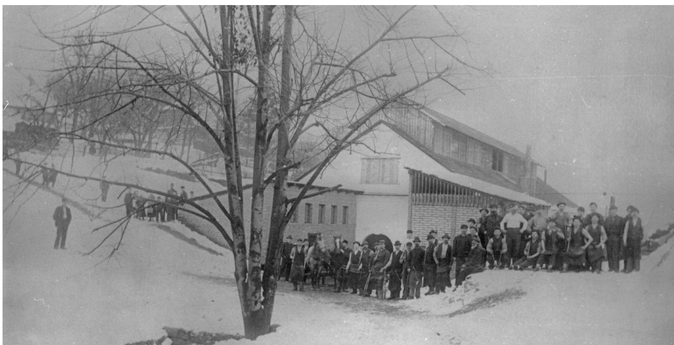
Obr. 18: Dobřív, Horní (Hořejší) huť, hamr – pohled na budovu hamru od jihu, patrné jsou ještě oba přístavky.
