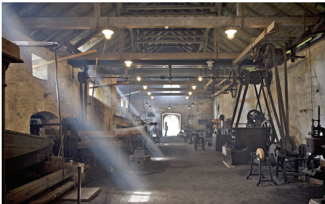
Obr. 6: Dobřív, Horní (Hořejší) huť, hamr – interiér budovy, průhled budovou k západu. Foto: Václav Marian, 2020
