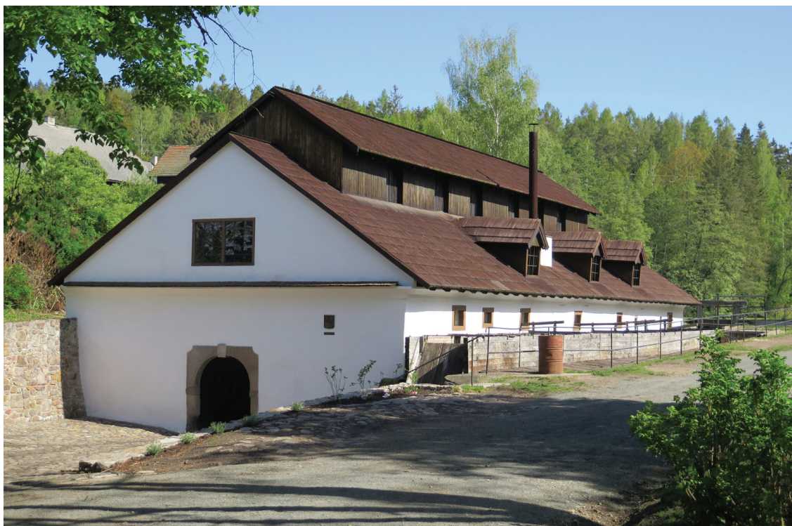
Obr. 1: Dobřív, Horní (Hořejší) huť, hamr (okr. Rokycany) – celkový pohled na objekt od jihu. Foto: David Tuma, 2020
