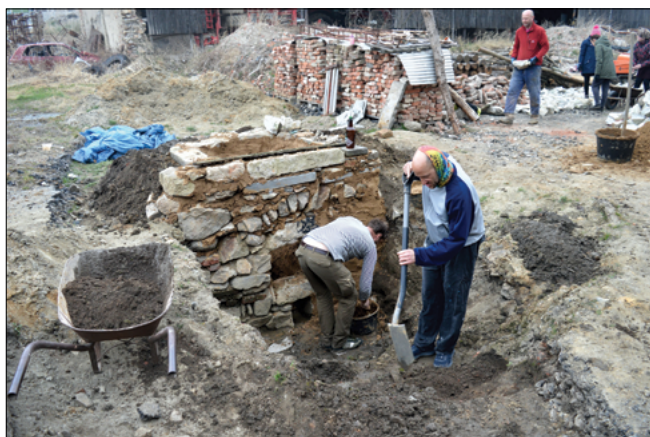
Obr. 3: Stavba pokusné vápenické pece. Foto: P. Kos
