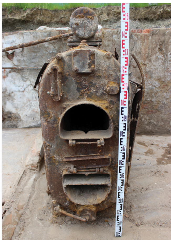
Obr. 11: Moravská Ostrava, ul. Velká. Kombinovaný parovodní kotel typu Střebel v odkrytém suterénu domu čp. 60. Pohled od SV. Foto: M. Kiecoň
