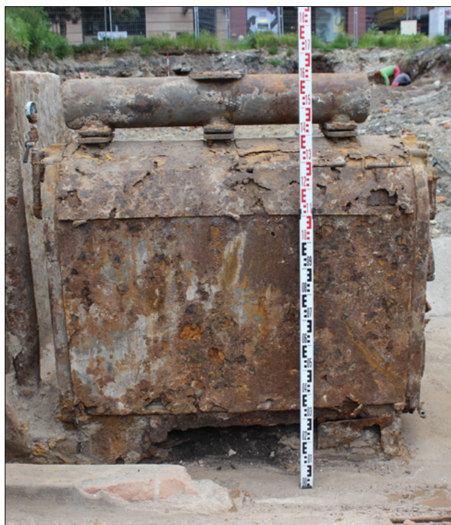
Obr. 12: Moravská Ostrava, ul. Velká. Kombinovaný parovodní kotel typu Střebel v odkrytém suterénu domu čp. 60. Pohled od JV. Foto: M. Kiecoň
