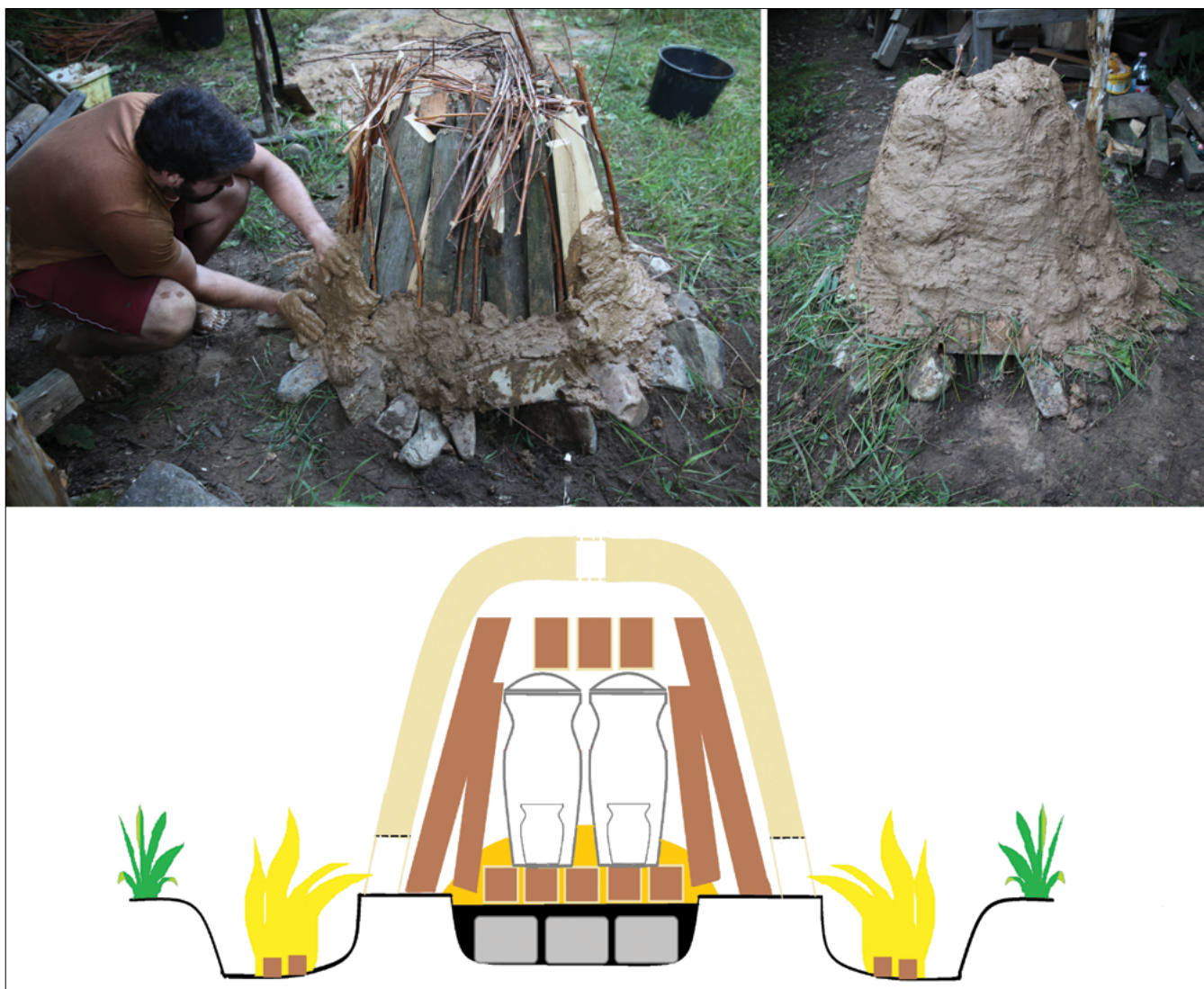
Obr. 4: Stavba milířovité pícky. Vlevo první vrstva omazu, vpravo hotová pícka. Dole schematický náčrt konstrukce. Foto: J. Figura, P. Macků 2021
