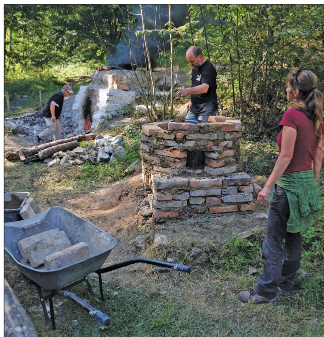
Obr. 2: Stará huť u Adamova, září 2020. Stavba dehtové pece, v pozadí již zapálená vápenka. Foto: O. Merta
