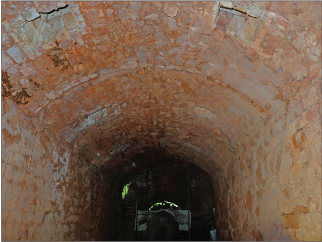
Obr. 8: Interiér cihelny s násypnými otvory topiva. Foto: P. Holub, 2020
