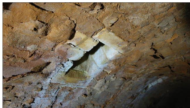
Obr. 10: Detail šamotových cihel na ústí násypného otvoru v klenbě pece. Foto: P. Holub, 2020
