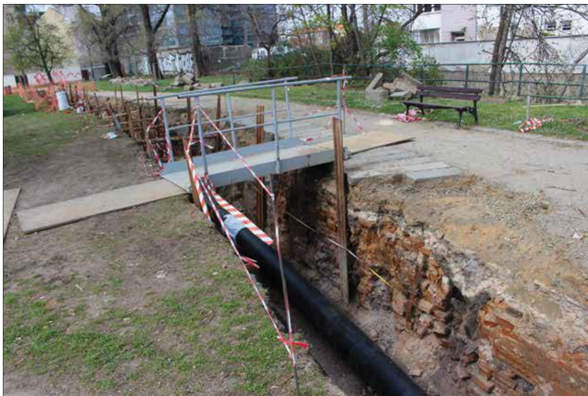
Obr. 3: Pohled na výkop horkovodu od jihovýchodu (foto Archaia Brno z.ú.)
