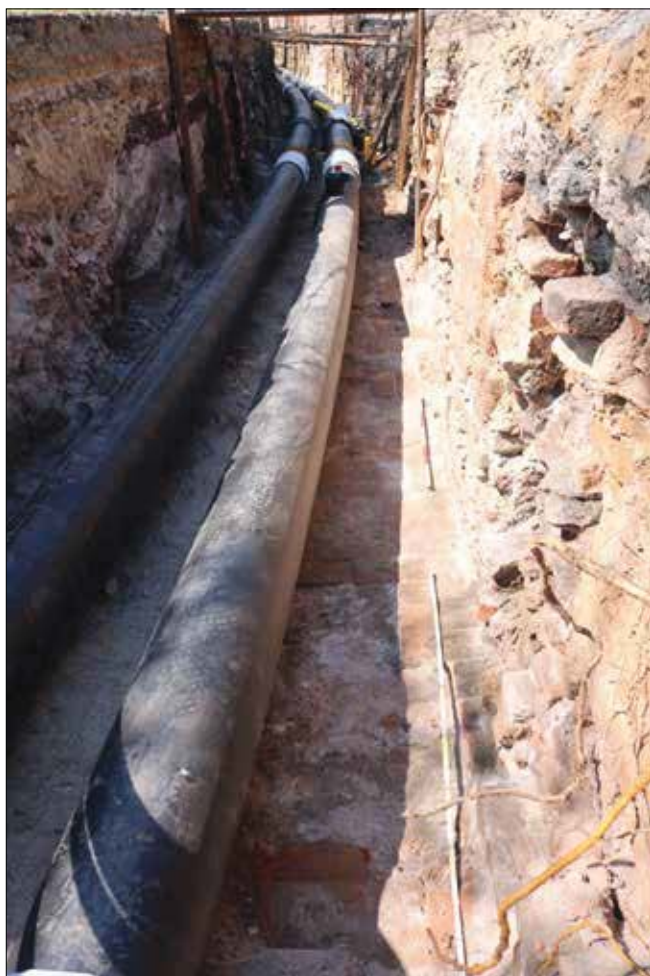
Obr. 8: Podlaha chodby barvírny s.j. 913 (foto Archaia Brno z.ú.)
