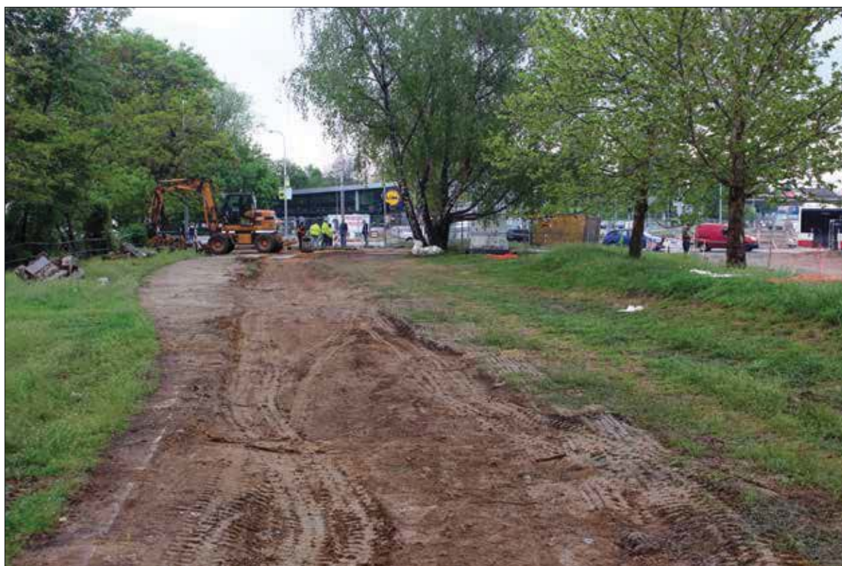
Obr. 10: Stav po ukončení akce, pohled od západu (foto Archaia Brno z.ú.)
