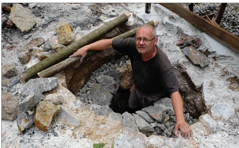
Obr. 1: Stará huť u Adamova, květen 2018. Z části vsázky je vystavěna klenba, na niž je poté navršena zbytek vápencové suroviny (Foto: Martin Barák)
