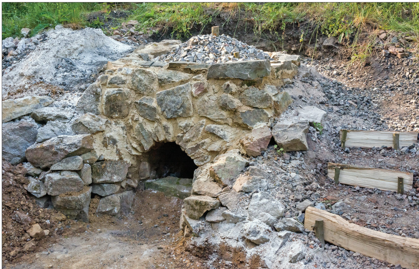
Obr. 2: Stará huť u Adamova, květen 2016, jednokomorová vápenná pec s připravenou vsázkou – ta bude ještě překryta hliněným „čepcem“. Foto Martin Barák
