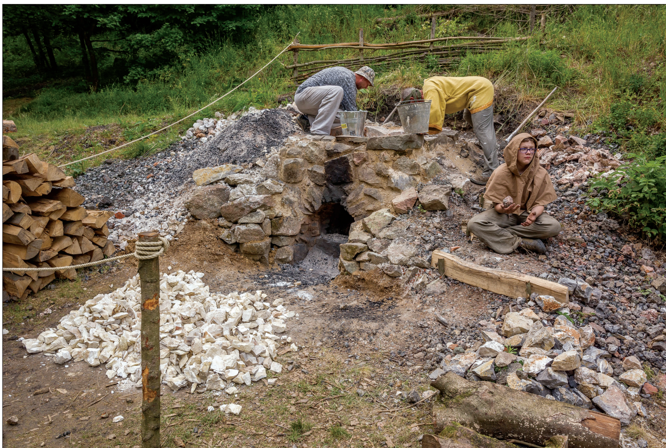
Obr. 4: Stará huť u Adamova, květen 2016, po částečném vychladnutí je z vápenné pece vybírán výpalek – vlevo vpředu. Foto Martin Barák
