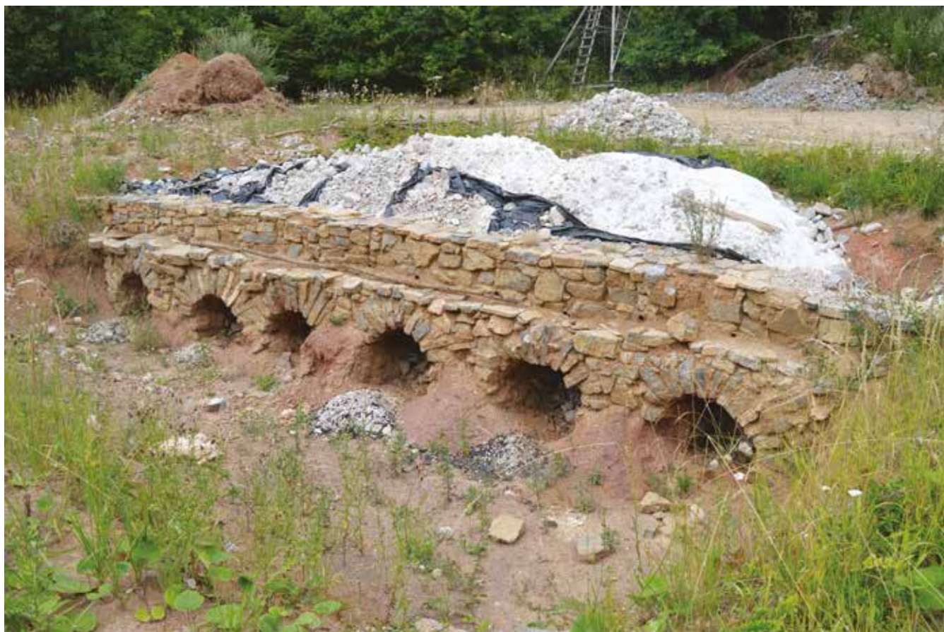
Obr. 17: Vzhled experimentální vápenné pece přibližně půl roku po výpalu; v šachtě pece patrný mohutný val samovolně vyhašeného vápna. Foto P. Kos
