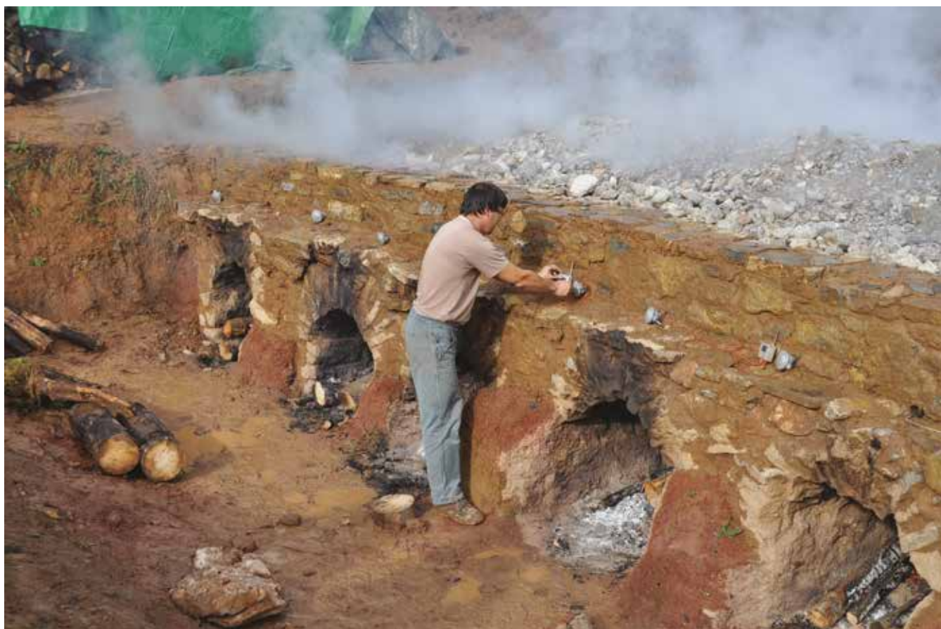
Obr. 10: Instalace termočlánků do ocelových chrániček zabudovaných v plentové zdi. Foto P. Kos
