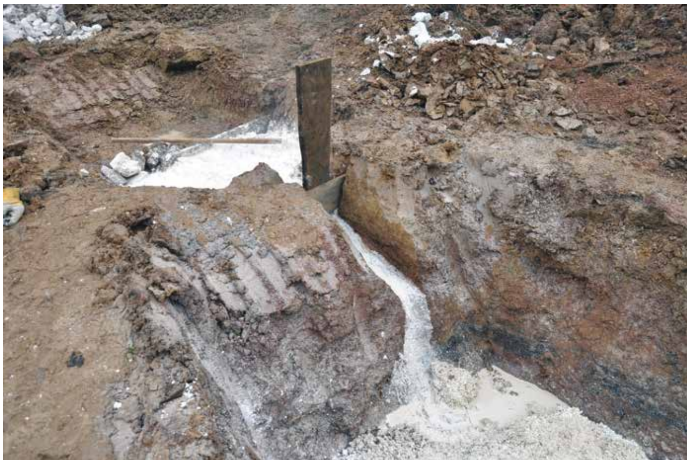
Obr. 16: Polní hasnice s hrazeným přepadem do vápenné jámy. Foto P. Kos
