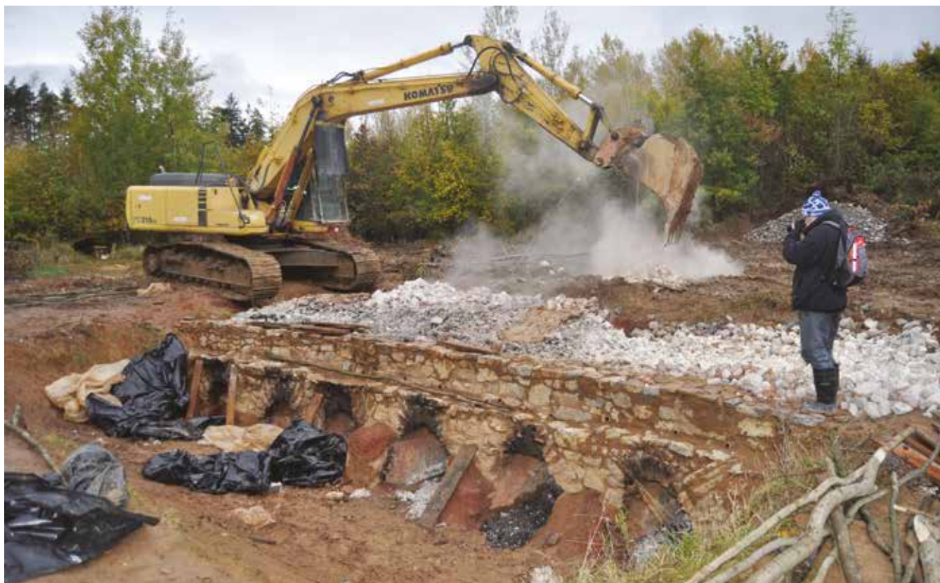
Obr. 15: Mechanizované rozebírání pece a vzorkování výpalku. Foto P. Kos
