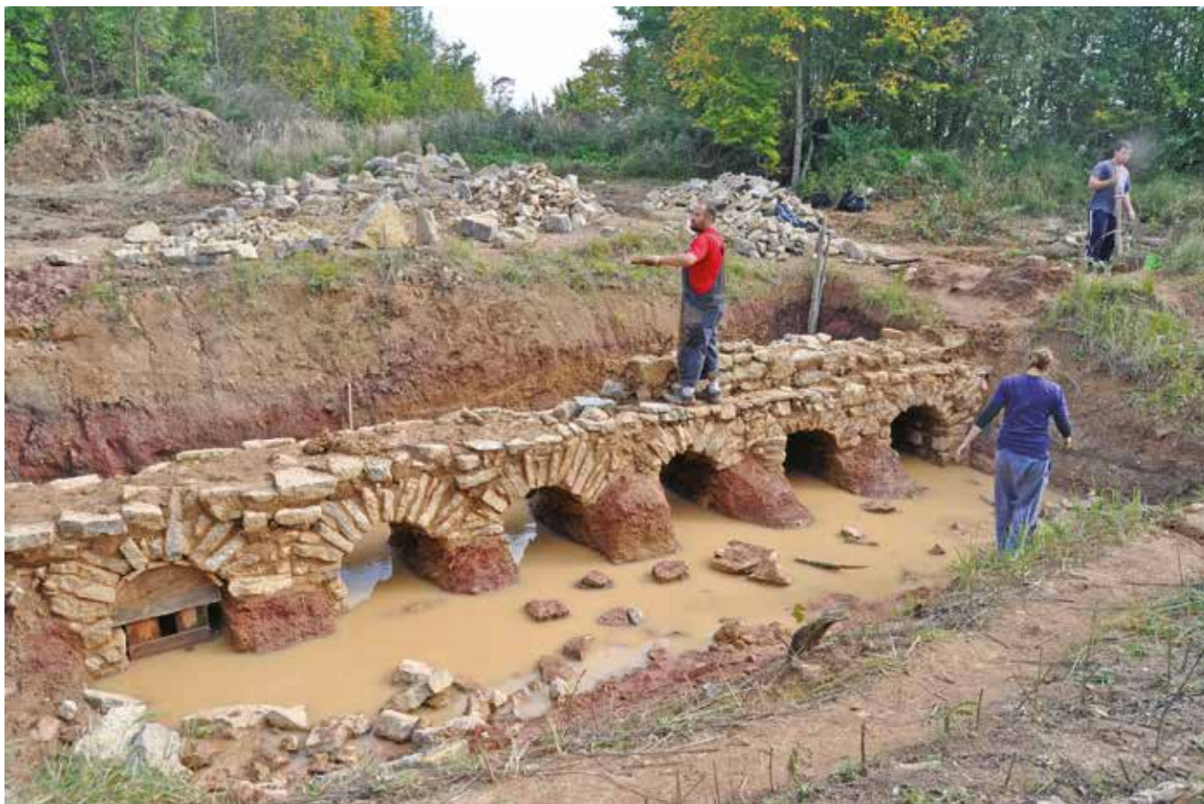
Obr. 5: Práce na rekonstrukci plentové zdi. Foto P. Kos
