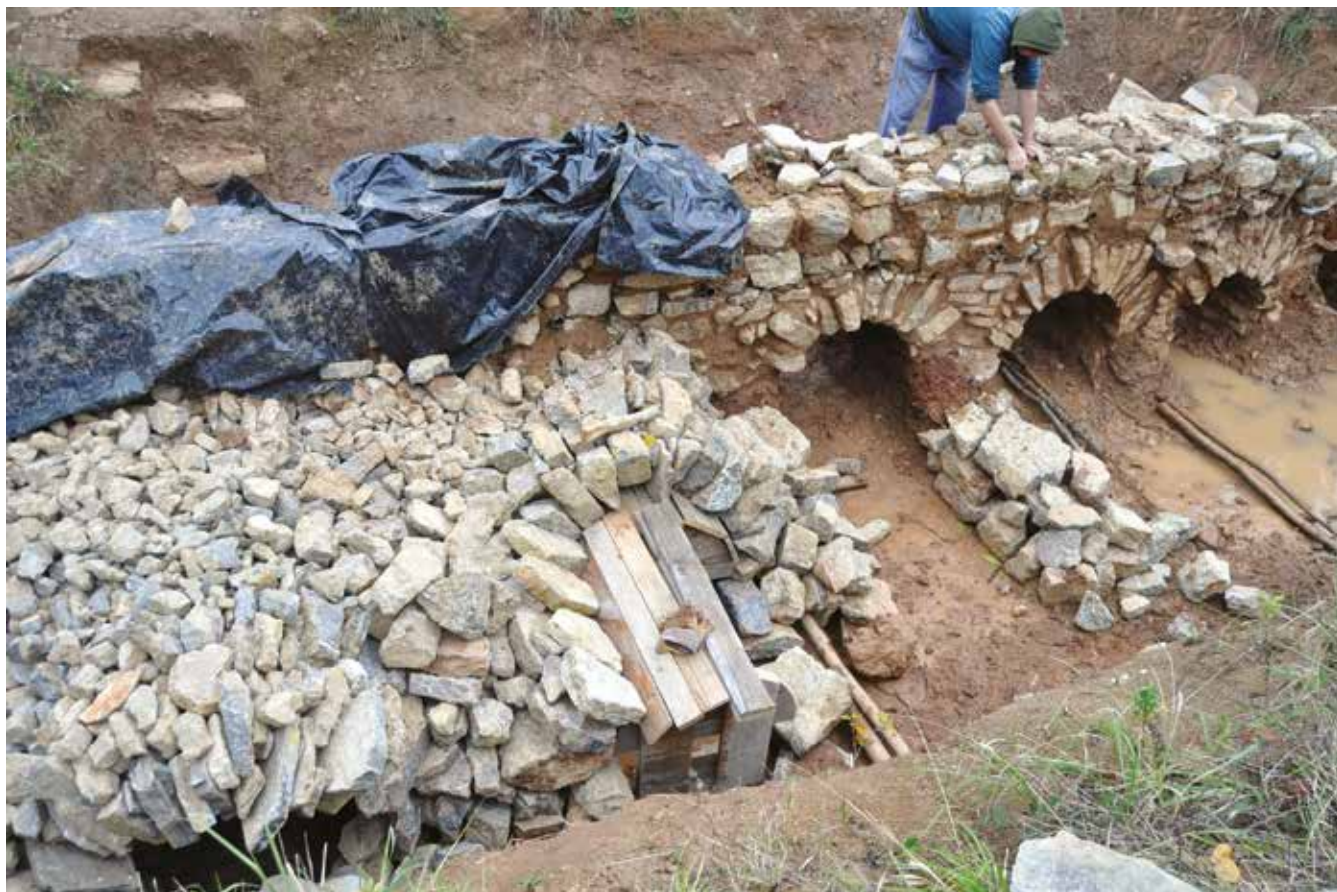
Obr. 6: Současně probíhající rekonstrukce plentové zdi a budování roštů na dřevěné šablony. Foto P. Kos
