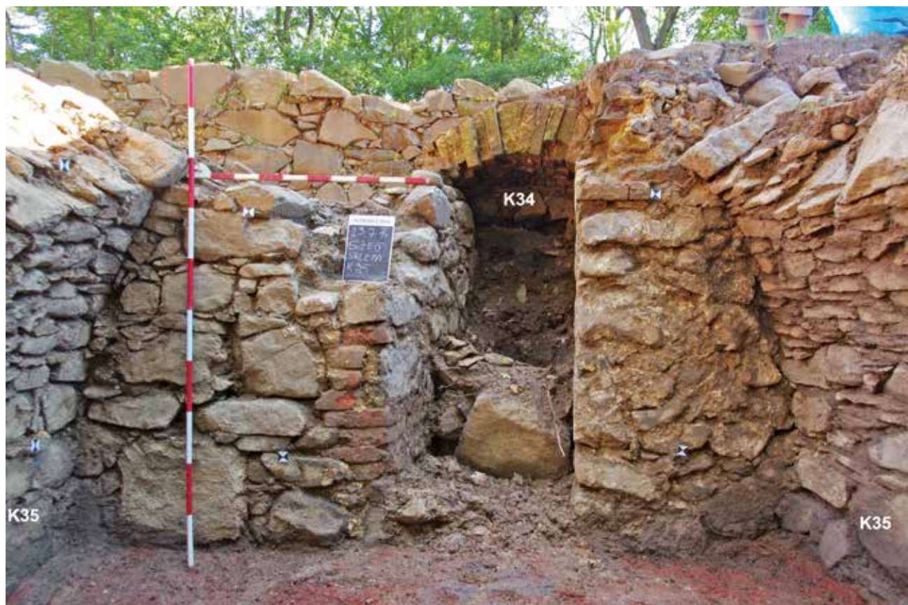
Obr. 4: Konstrukce K34 zbudovaná z cihel a kamene místní provenience pojená maltou a K35 vystavěná z místního kamene pojená jílem. Pohled od jihu. Foto L. Galusová
