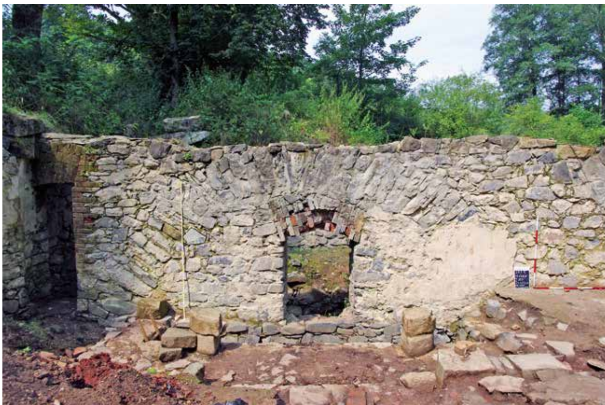
Obr. 5: Návodní zeď mlýna K20. Ve zdivu patrný mohutný vynášecí pas. Pohled na konstrukci od východu. Foto L. Galusová
