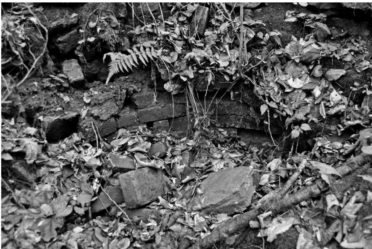
Obr. 6. Detail cihelné vyzdívky jedné z vápenek v trati U Ketkovského mlýna. Foto P. Kos
