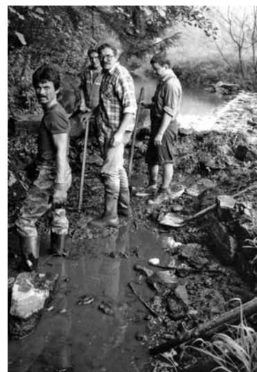
Obr. 21: Brdičkův mlýn v Hamrech nad Sázavou, v tomto případě úprava a oprava vtoku mlýnského náhonu. Na „Brdičáku“ jsme strávili hodně času, ať již při různých brigádách, či během dovolených suplujících letní tábory. Od leva Petr Kavan, Ivo Štěpánek, JM a Petr Nekuža (1990 či 1991)
