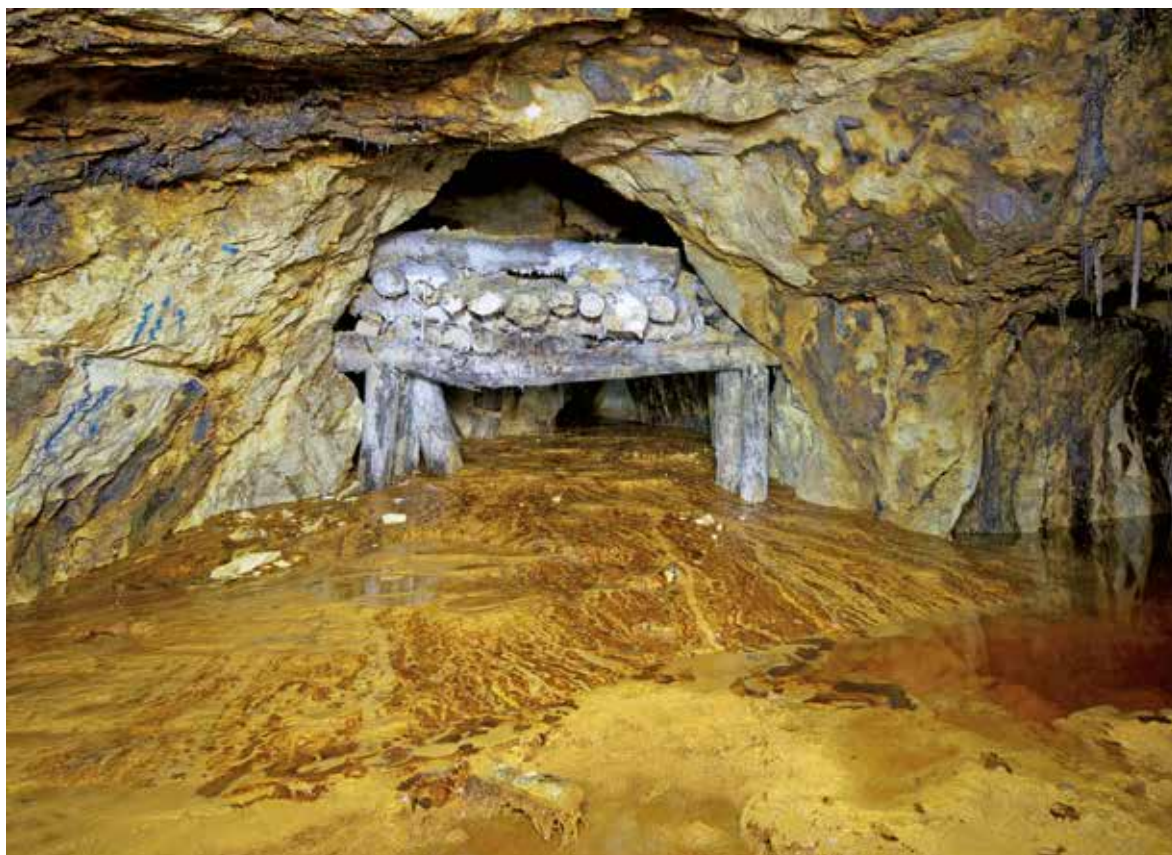
Obr. 24: Postupný zánik štol na nejnižších patrech, Cetate. Většina materiálu pochází z vodou protékaných dobývek a komor, které byly na spodních patrech zasypány. Zároveň hrozí průvaly takto nastoupané vody a bahna. Objem větších „jezer“ se pohybuje v řádech tisíců m 3 . Foto I. Rous
