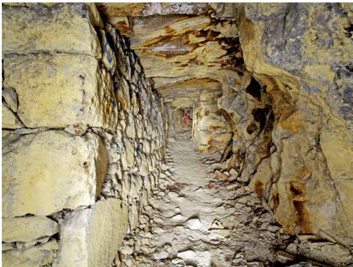
Obr. 23: Dobývka a zakládka z 16.–18. století, Orlea. Takto umě zhotovené zakládky se vyskytují v Rosia Montaně pouze v masivu Orlea, a souvisí pravděpodobně s exploatací štol Rakoci. Foto I. Rous
