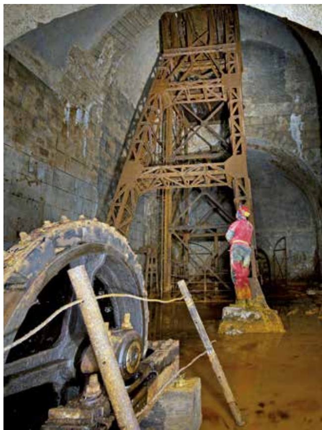
Obr. 18: Slepá jáma Tarina s původním vybavením z první poloviny 20. století. Obsluhovala dopravní patro v hloubce 60 metrů pod hlavní štolou 23. August. V komoře šachty je velké množství dochovaných různojazyčných nápisů z období celého 20. století. Foto I. Rous
