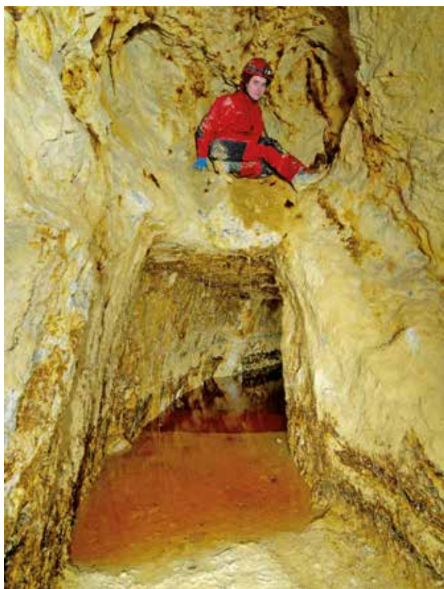
Obr. 16: Typický profil římských štol v Rosia Montaně. Nedokončené hloubení. Foto I. Rous
