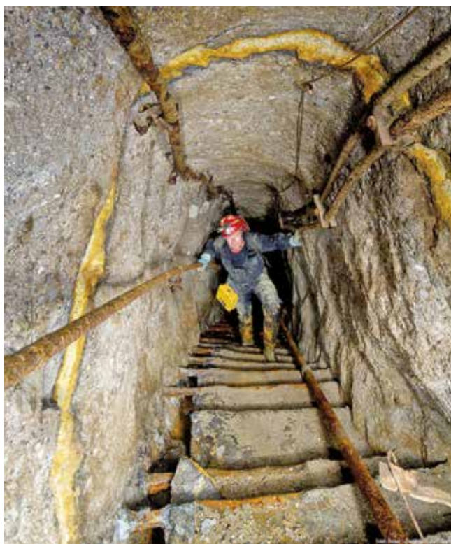
Obr. 9: V dnešním muzejním areálu se nacházela jáma vedoucí na hlavní dopravní štolu (Galeria Principal 23. august). Vedle šachty se pro přístup na hlavní štolu používala i letitá schodišťová chodba napojená přímo na cáčovnu. Štola si zachovala v horní polovině profilu na několika místech typický lichoběžníkový profil. Počva, respektive schodiště bylo mnohokrát obnovováno. Foto I. Rous
