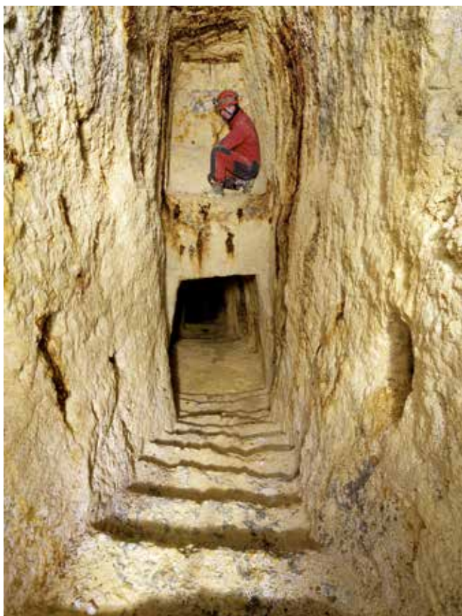
Obr. 10: Římská úpadnice vycházející z původní horizontální štoly, Carnic. Foto I. Rous
