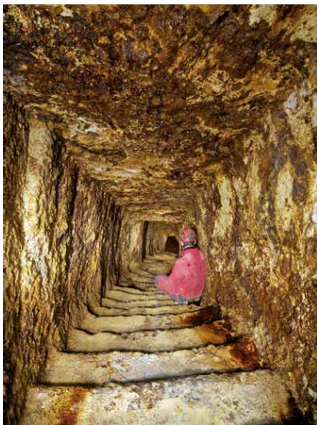
Obr. 11: Římská úpadnice se schody a otvory pro lampy, Carnic. Foto I. Rous
