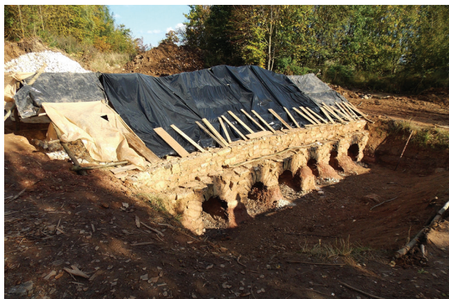
Obr. 4: Před rozebráním obsahu je nutné nechat pec několik dní chladnout, Mokrá-Horákov, okr. Brno-venkov. Foto O. Merta 2014
