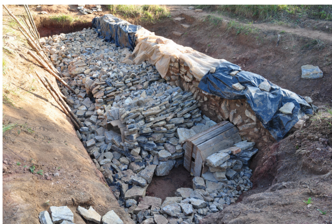
Obr. 1: Plnění peciště vápencovým materiálem, stavba kleneb roštů za otopnými kanály, Mokrá-Horákov, okr. Brno-venkov. Foto O. Merta 2014
