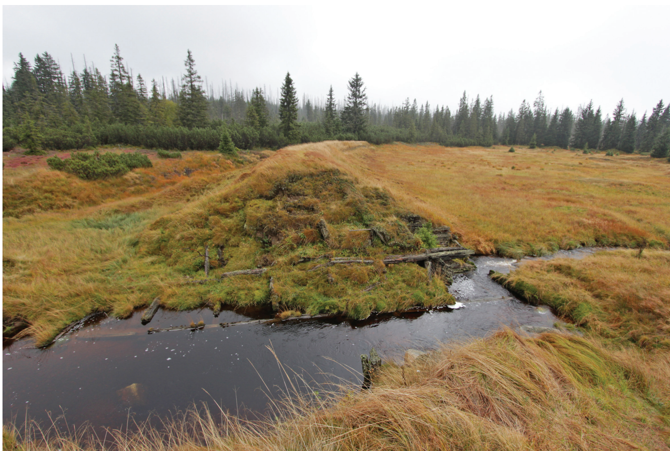
Obr. 19: Pohled na profil průlomu hráze Roklanské nádrže s dřevěnými konstrukčními prvky, pohled od SZ. Foto T. Blažková 2013
