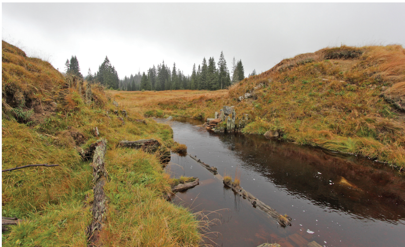
Obr. 20: Pohled na profil průlomu hráze Roklanské nádrže s dřevěnými konstrukčními prvky, pohled od SV. Foto T. Blažková 2013
