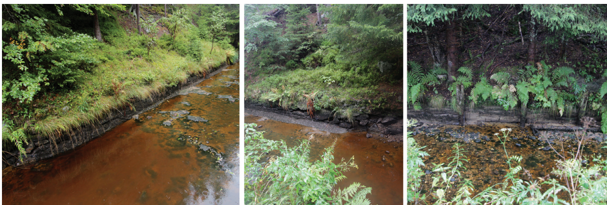
Obr. 7: Různé úpravy stěn kanálu, 1 – vytesání do svahu, 2 – podepření svahu zdí, vyskládanou z kamenů, 3 – podpůrná výdřeva. Foto T. Blažková 2013
