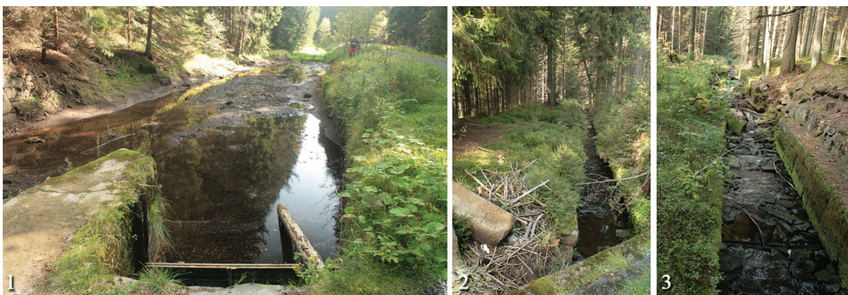
Obr. 10: Skluz do Sekerského potoka. 1 – odbočka do skluzu, 2,3 – skluz. Foto T. Blažková 2009
