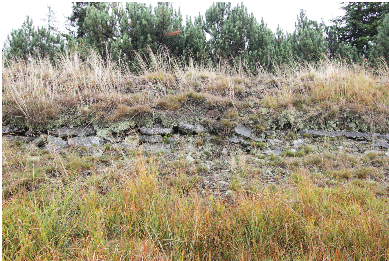
Obr. 21: Kamenné konstrukční prvky na vnitřní straně hráze. Foto T. Blažková 2013
