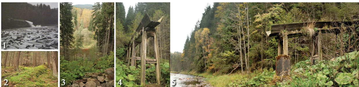
Obr. 9: Skluz do Křemelné. 1 – skluz ve třicátých letech 20. století (Běl 1998, 20), 2 – skluz v betonovém potrubí v prudkém svahu, 3 – pohled na dřevěné zakončení skluzu, 4, 5 – dřevěná rampa do Křemelné. Foto T. Blažková 2009.
