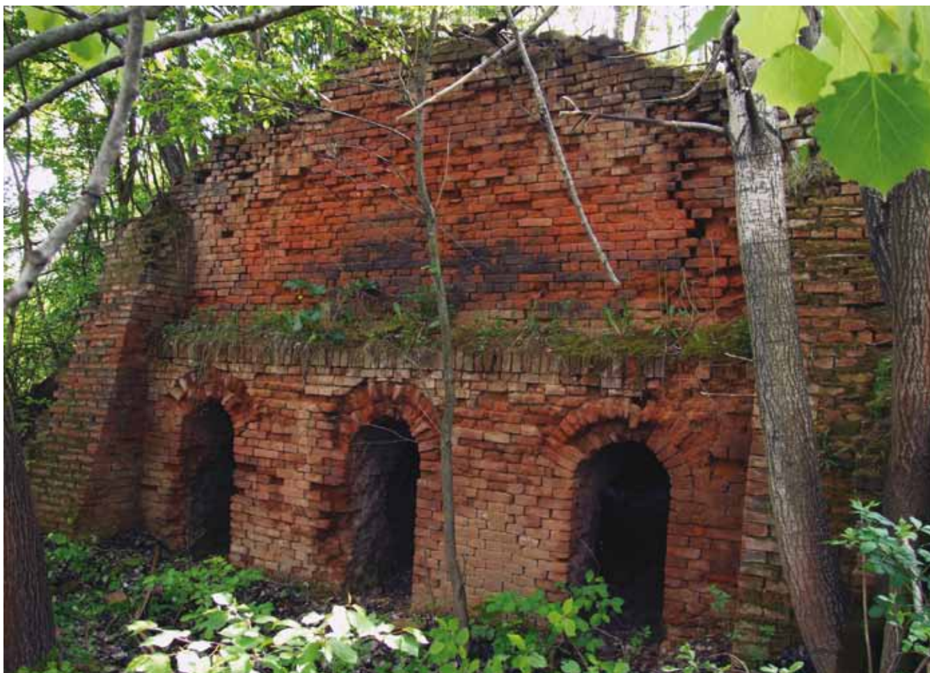
Obr. 13: Prietrž, okr. Senica, Slovensko. Čelná stena žiarovky so zaklenutou vypaľovacou komorou. Stav v roku 2010. Foto: P. Grznár
