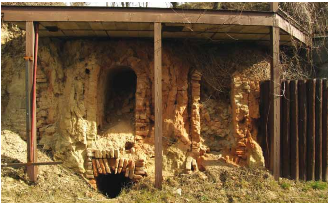
Obr. 14: Veselé, okr. Piešťany, Slovensko, obslužné a vykurovacie otvory v čelnej stene žiarovky. Stav v roku 2010. Foto: J. Čáni
