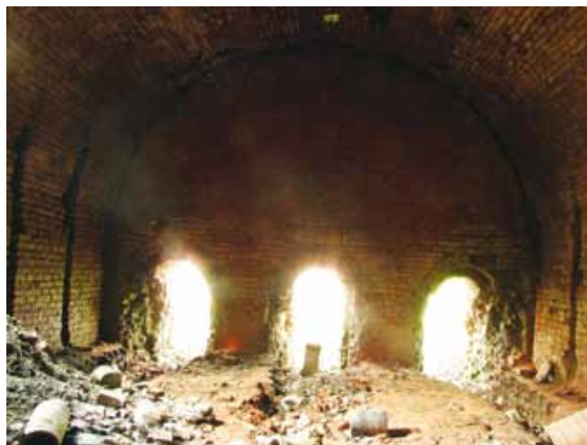
Obr. 11: Prietrž, okr. Senica, Slovensko. Zaklenutie vypaľovacej komory žiarovej tehliarskej pece tzv. nemeckej. Stav v roku 2010. Foto: P. Grznár
