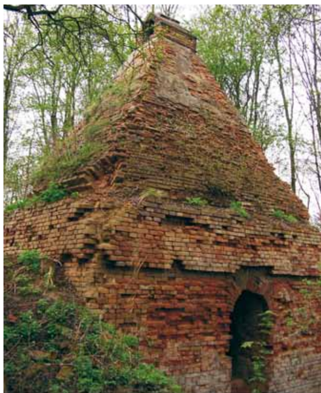
Obr. 11: Prietrž, okr. Senica, Slovensko. Zaklenutie vypaľovacej komory žiarovej tehliarskej pece tzv. nemeckej. Stav v roku 2010. Foto: P. Grznár
