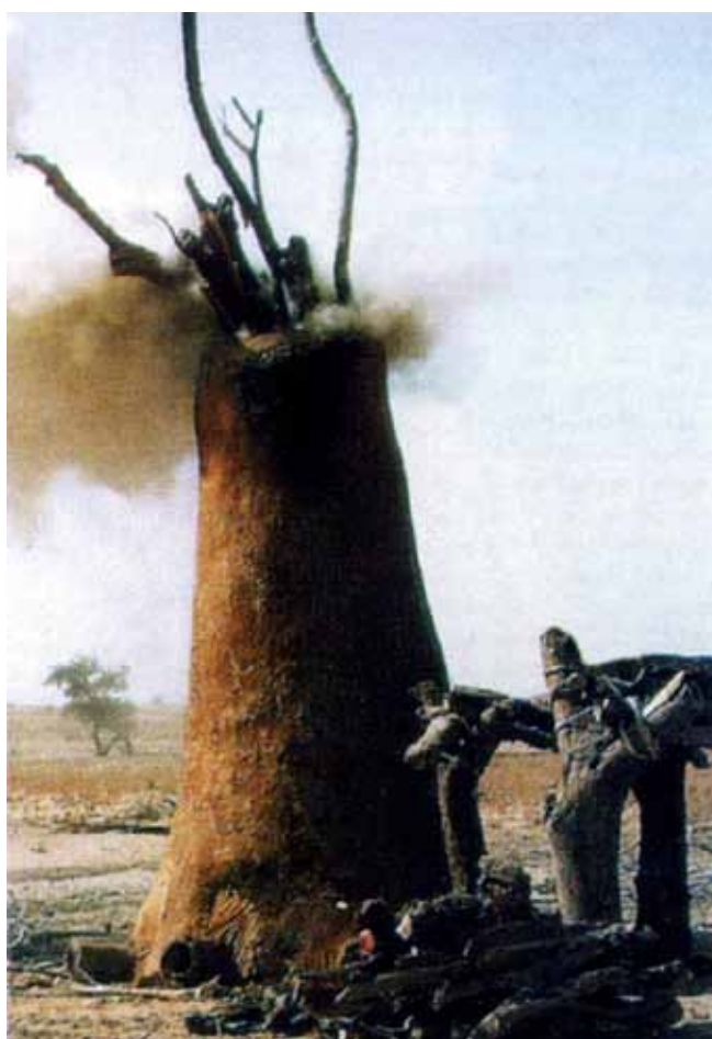
Obr. 26: V některých oblastech se pro nás středověká technologie dochovala až do dvacátého století – šachtová kusová železářská pec z oblasti západní Afriky, 20. století – (Yalcyn 2004, 221)
