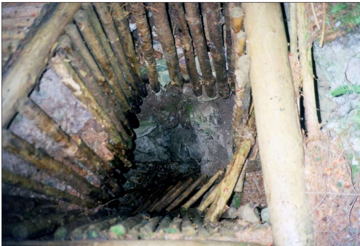
Obr. 10: Hranovnica – pohľad do šachtice H-1 s výdrevou
