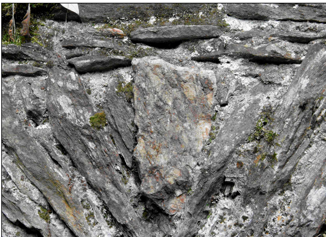
Obr. 5 Detail klenby výpadové branky
