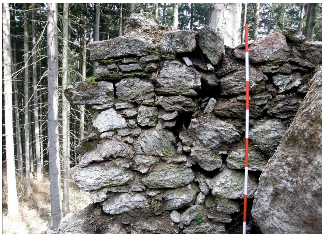
Obr. 2 Dochovaná část vnější obvodové hradby
