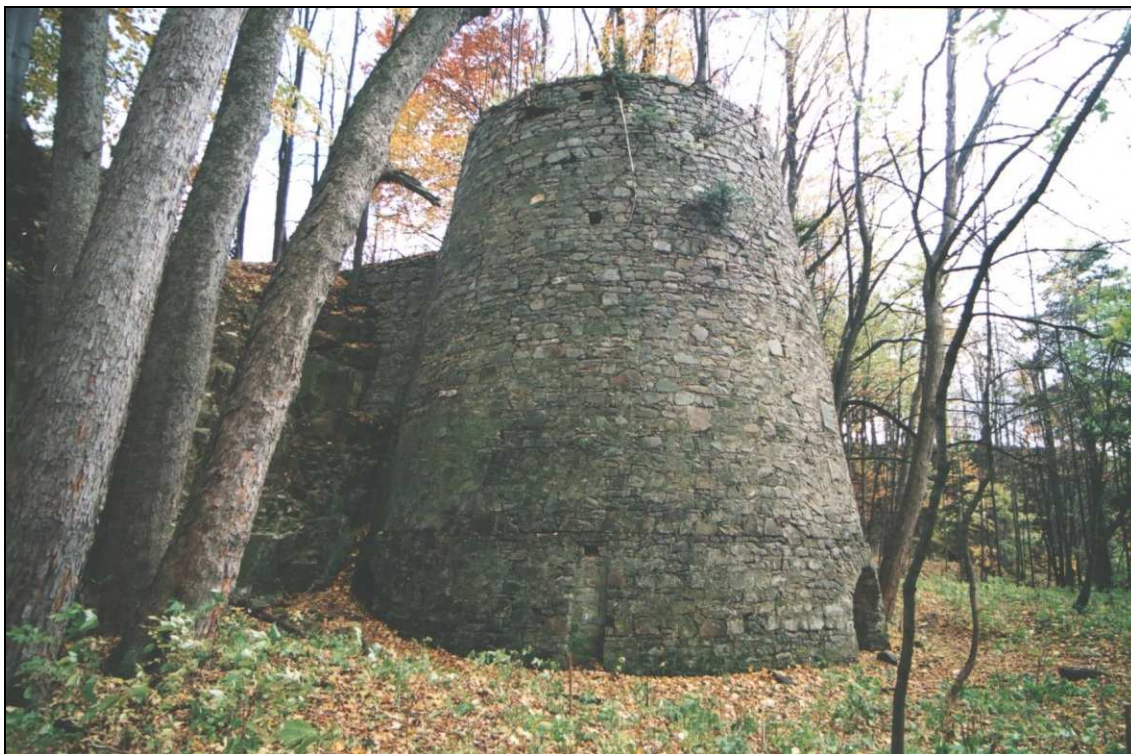
Obr. 2 Supíkovice, jednoduchá šachtová vápenka, stav k r. 2003
