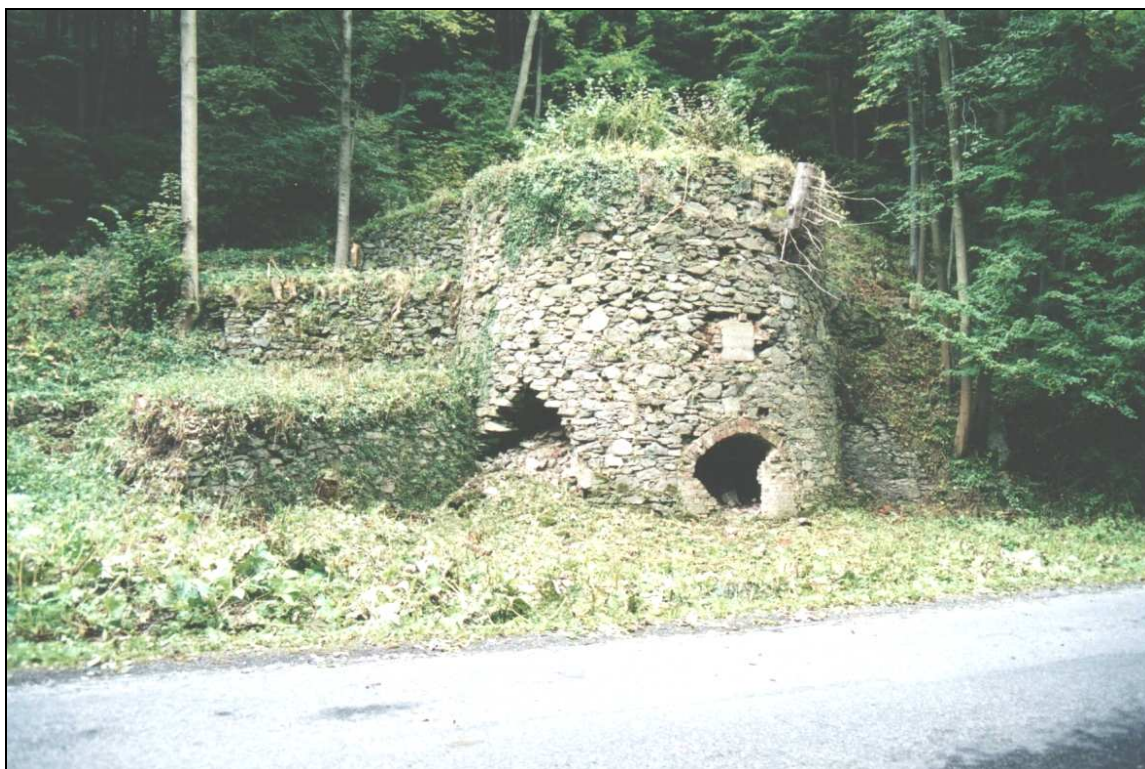
Obr. 1 Javorník, jednoduchá šachtová vápenka, stav k r. 2003
