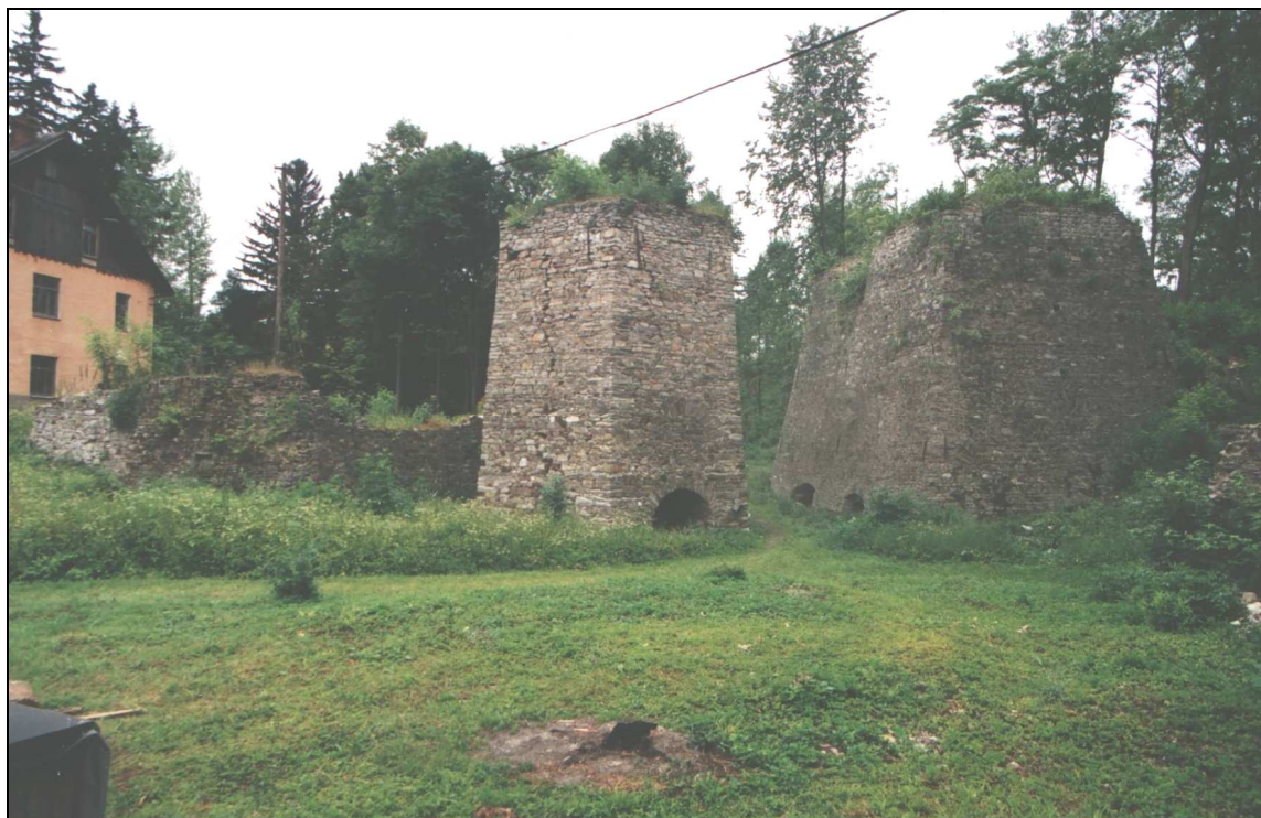
Obr. 5 Velké Kunětice, vpravo dvojitá šachtová vápenka, vlevo jednoduchá šachtová vápenka, stav k r. 2003
